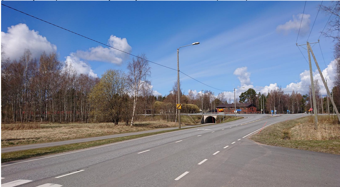
Kuva 3.2 Valtatie 23 ja maantien 2600 risteysalueen liikenneympäristöä. Taustalla näkyy Kivijärventien länsipuolella sijaitseva hoivapalvelurakennus. Suunnittelualue jää kuvassa etuvasemmalle (Arto Remes 29.4.2021)
