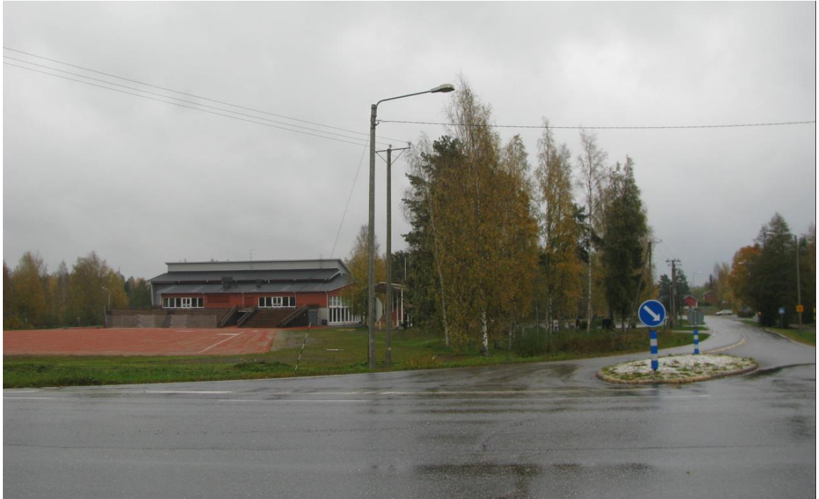
Kuva 3.5 Pomarkun keskuskenttä, monitoimihalli ja vanha katsomorakennus valtatie 23 ja maantien 2600 (Harjantien) risteysalueelta kuvattuna (Arto Remes 6.10.2020)
